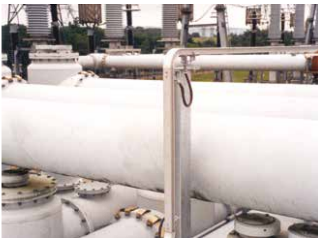
Mit dem Söll MultiRail-System sind vertikale Abschnitte von bis zu 1 Meter zulässig.
